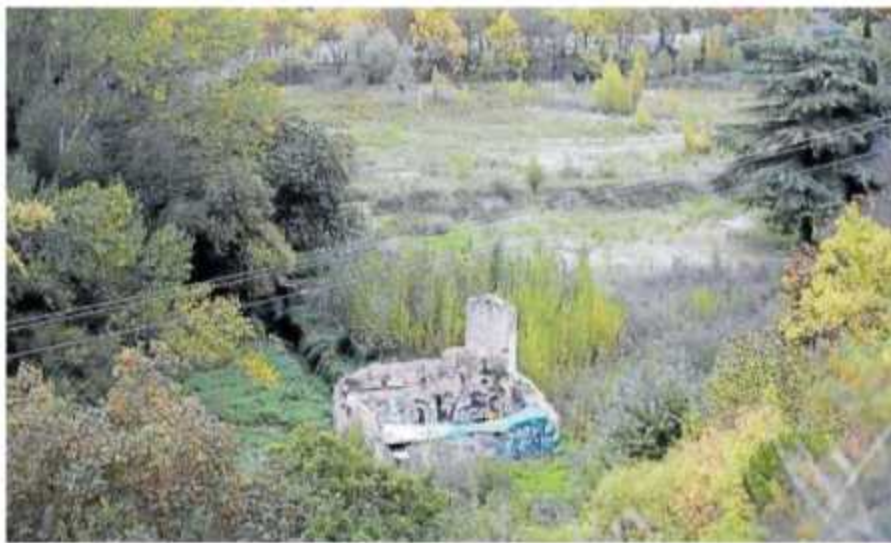
Imagen de los restos del molino de Ilundáin, después del incendio que afectó a la harinera. Foto: Ihergusa
